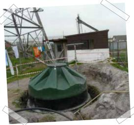
IN A BIODIGESTER ORGANIC WASTE **DECAYS AND PRODUCES** BIOGAS. THE GAS IS COLLECTED THROUGH PIPES AND USED AS A FUEL TO PRODUCE HEAT.
